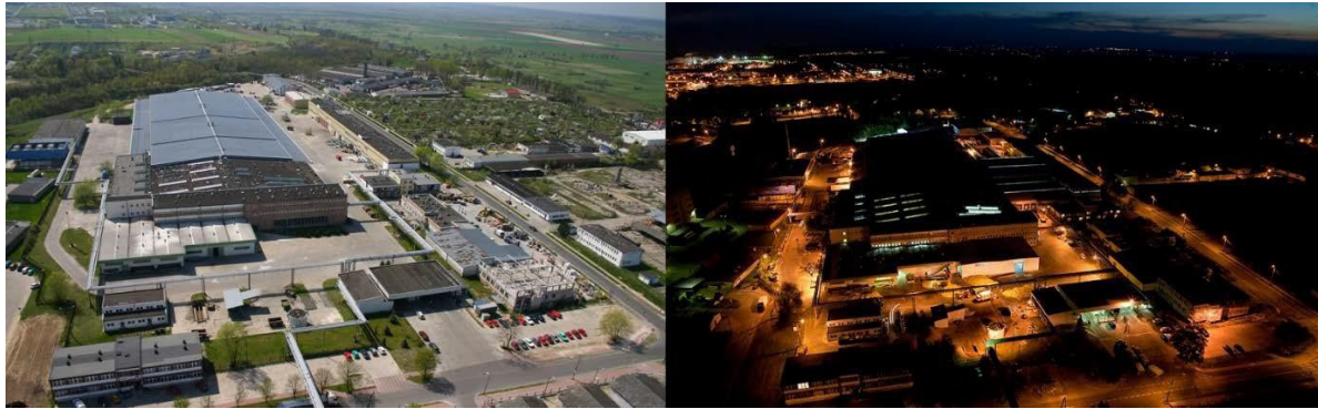
Warmińskie Zakłady Przetwórstwa Owocowo-Warzywnego in Kwidzyn (left – 2004, right – 2009), Poland [ http://www.warzywakwidzyn.pl/en/Home/About-Kwidzyn/The-Beginnings-of-WZPOW-Kwidzyn ]
