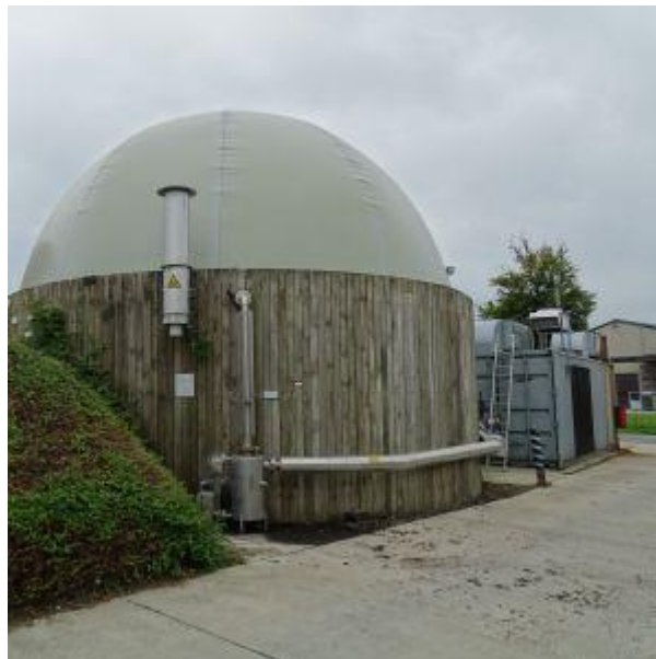
Figuur 2: Pocketvergistingsinstallatie bij Inagro.
